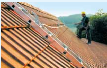
Aufstieg und Anseilschutz über geprüfte Dachhaken
