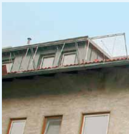
Stabile Dachschutzblenden, rückverankert und gegen Ausheben gesichert
