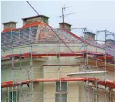
Stahlrohrgerüst als Dachfanggerüst mit Seitenwehren und Schutznetz
