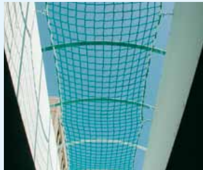
Sicherung einer Oberlichte
