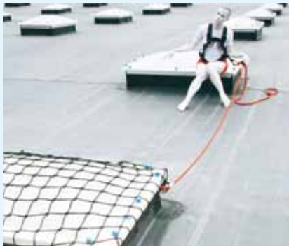
Sicherung von Dachöffnungen
