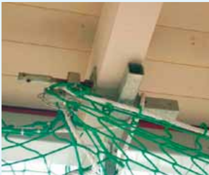
An den Sparren befestigte Konstruktion mit Netz
