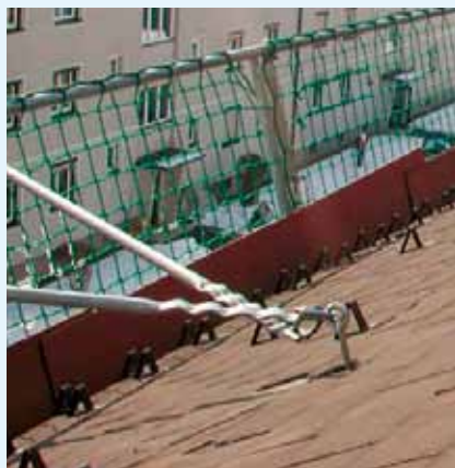
Stabile Dachschutzblenden, rückverankert und gegen Ausheben gesichert
